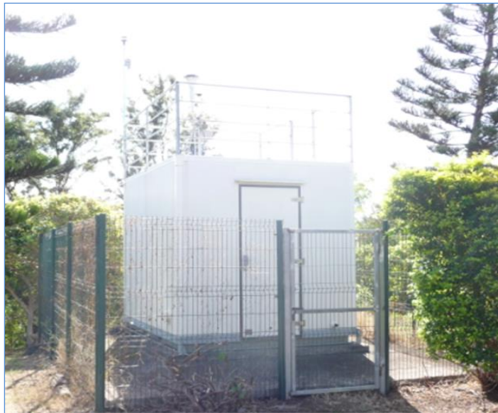
Station de mesures - Parvis de Notre Dame de Lourdes
