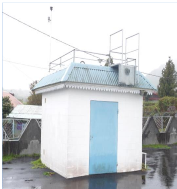
Station de mesures - Bourg Murat
