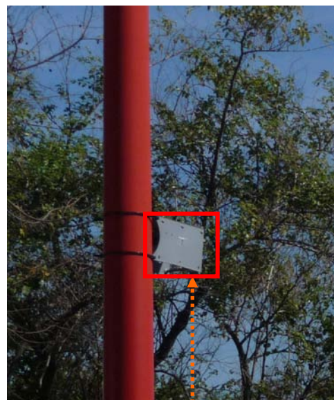
Figure 2 : Photographie présentant les capteurs à échantillonnage passif installés sous abri sur un poteau d'éclairage public (Source : ORA).
