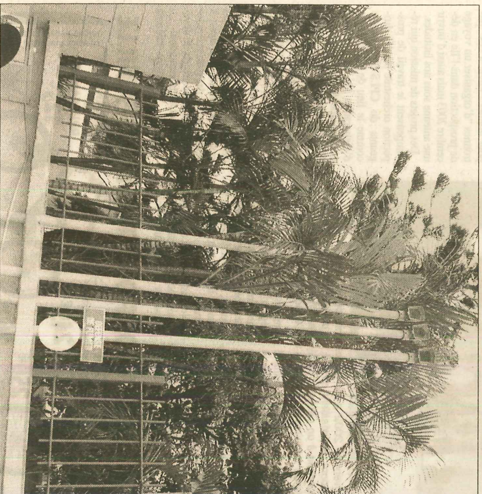
Les sociétés distributrices de carburant doivent modifier les systèmes d'évents à la sortie des cuves dans les stations-service. Un double tuyau récupérateur de vapeur captera les émanations de benzène et autres produits toxiques.
