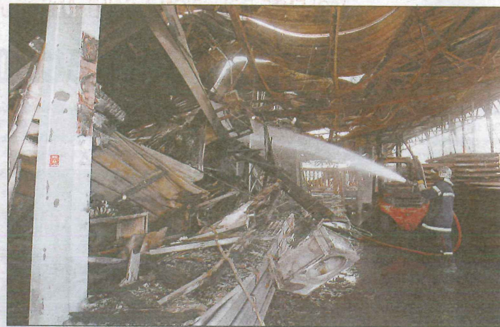
Les pompiers ont arrosé l'entrepôt une grande partie de la journée pour éteindre les derniers foyers.
