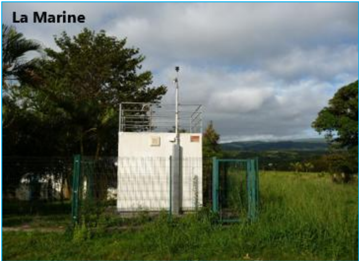
Figure 2 : Station La Marine à proximité de la centrale thermique d'Albioma Bois Rouge (Crédits photos : ©Atmo Réunion).
