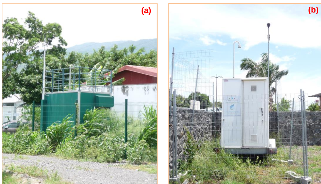
Figure 2 : Stations fixes implantées dans l'enceinte (a) du centre pénitentiaire du Port - CPE et (b) de la maison de quartier 'Terrain de Sel' - MQT (b) (Crédits photos : © Atmo Réunion).
